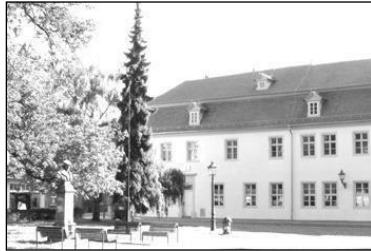
Bugenhagenhaus, Kirchplatz 9 Lutherstadt Wittenberg
