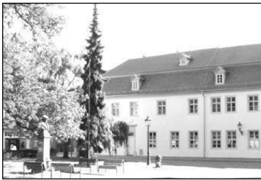
Bugenhagenhaus, Kirchplatz 9 Lutherstadt Wittenberg
