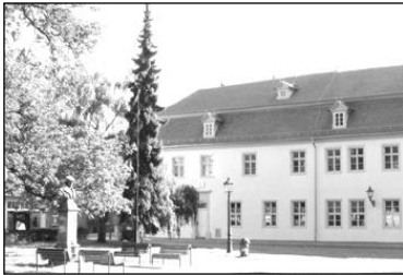
Bugenhagenhaus, Kirchplatz 9 Lutherstadt Wittenberg
