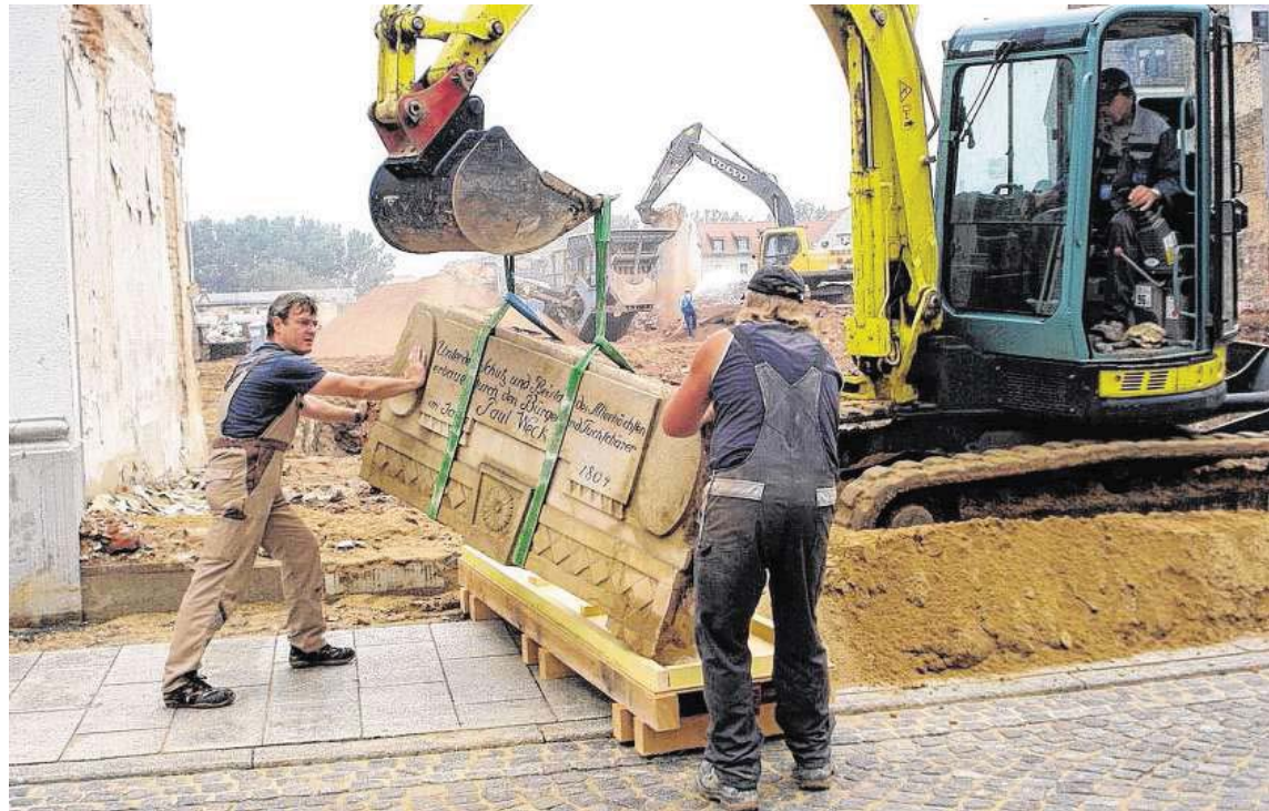
Das Paul-Weck-Portal beim Abtransport. Das gute Stück liegt jetzt in einem städtischen Depot.
