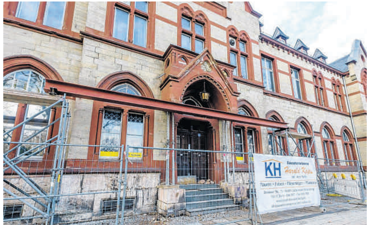
Das Portal an Wittenbergs Hauptpost wird saniert.
