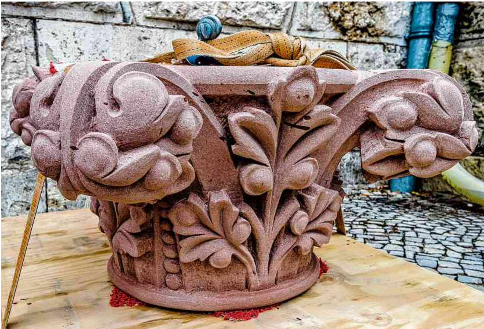
Eines der beiden Kapitelle, die künftig wieder die Säulen des Portals der Hauptpost krönen werden. Sämtliche Teile wurden neu angefertigt.
