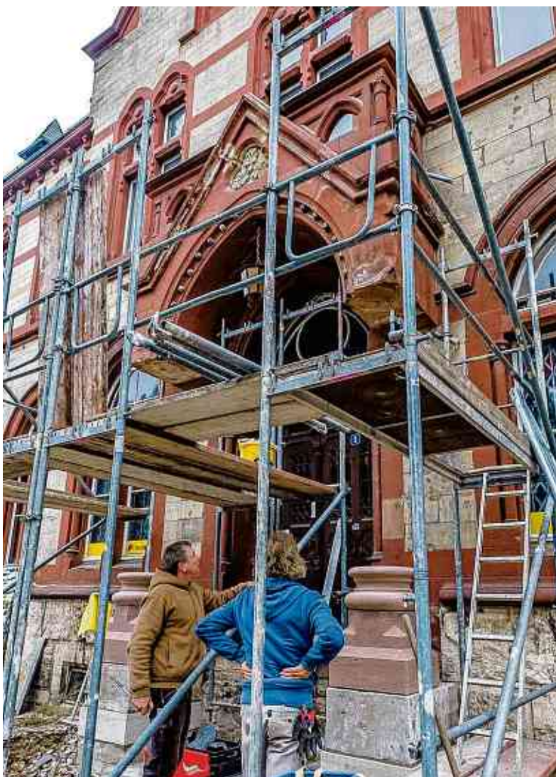
Steinrestaurator Peter Hoffmann (rechts) hat am Donnerstag mit dem Aufbau des Portals begonnen. Am Montag soll es fertig sein.
