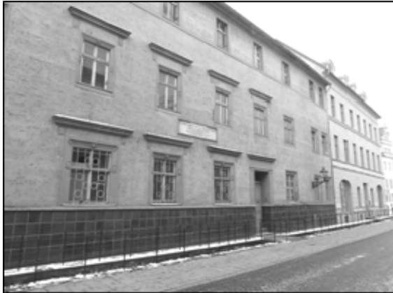
Das Alte Gymnasium, in der Jüdenstraße, Altstadt, erbaut um 1564
