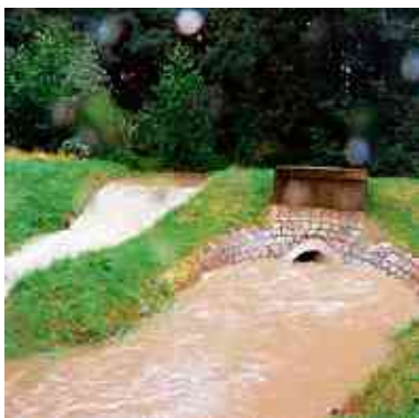
So sieht das ungleich kleinere Drosselbauwerk in Straach aus. FOTO: ECKARDT
