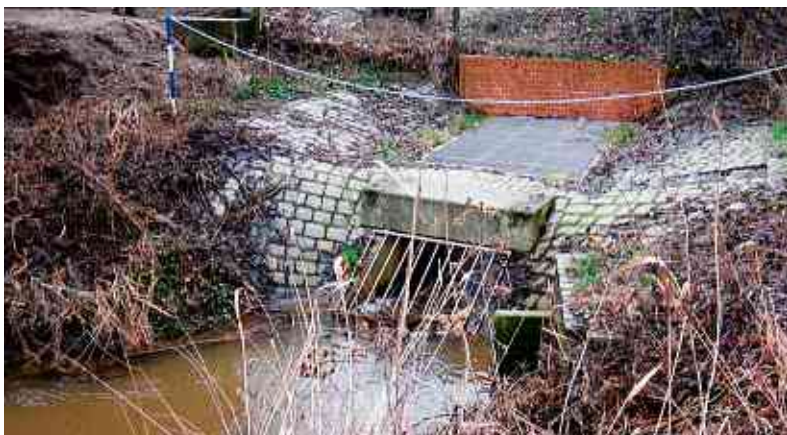
Neuralgischer Punkt. Mit dem geplanten Becken soll auch dieser Übergang zum verrohrten Teil des Rischebachs neu gebaut werden. FOTO: ENTWÄSSERUNGSBETRIEB
